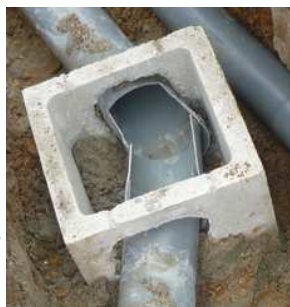
betona rigardilo por kanalizaco
