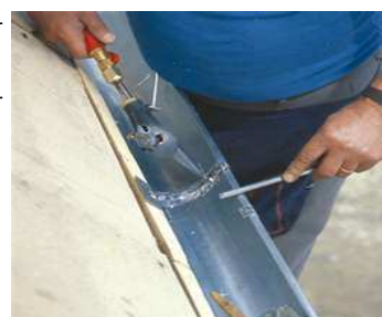
lutado sur pluvkanaletoj
