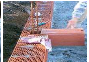
intersekco inter apogmuro kaj intermuro
