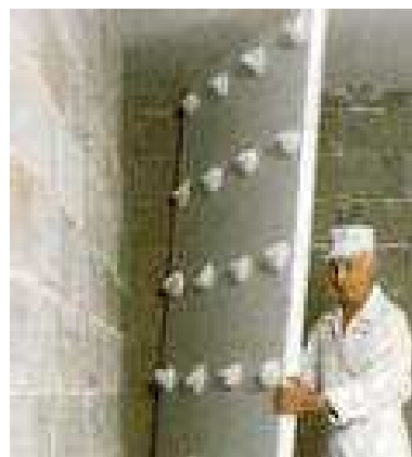
adhera mortero por gipsopanelo
