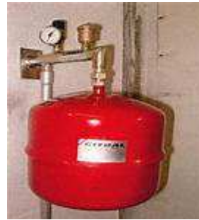
ekspansia vaso por hejtcirkvito
