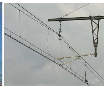
fervoja supertraka kontakta lineo
