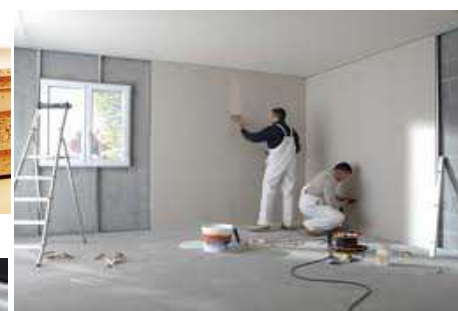
muntado da gips-paneloj sur rajloj
