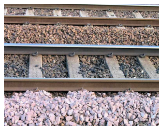
balasto sub trako (gruzo por bloki ŝpalojn)
