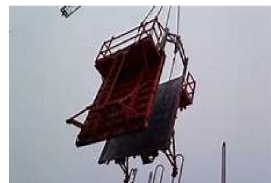
porbetona panelomuldilo
