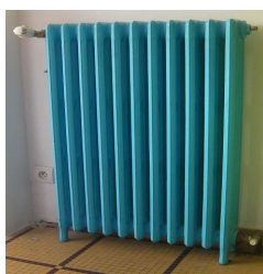
varmakva hejtilo por centra hejtado (radiatoro)
